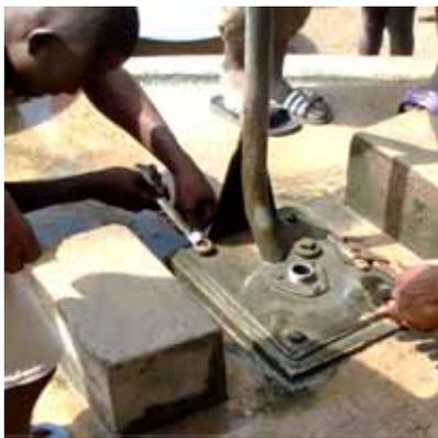
**Photo 45** Enlever les écrous des boulons d'ancrage
