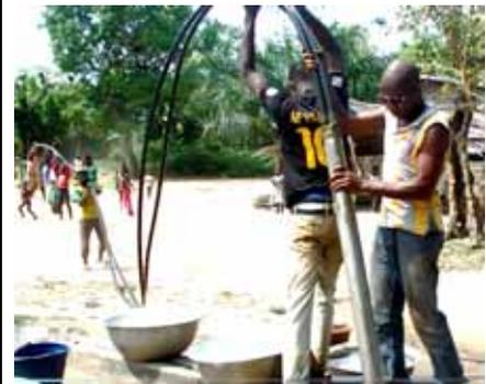
**Photo 47** Extraire les tuyaux et le cylindre complet
