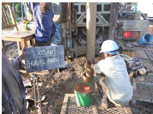
**Figure 4.19 Mise en Place du Gravier**
