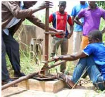
**Photo 13 Démonteur les tubes galva pâr unités**
