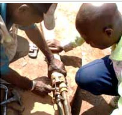
**Photo 48** Démontér le cylindre
